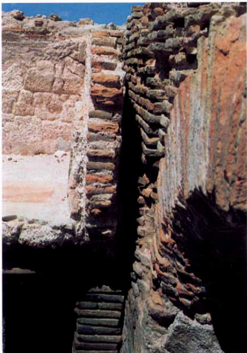
Fig. 30. Particolare della struttura muraria ad intercapedine.
