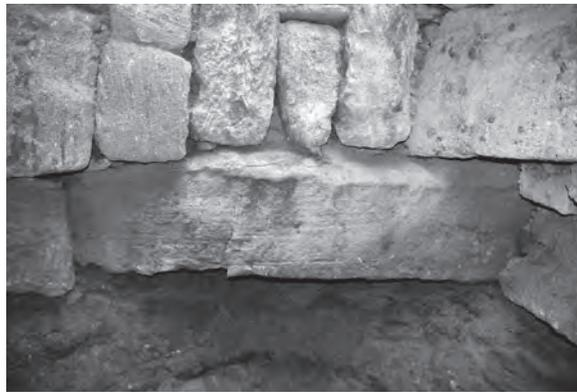
Fig. 4 - Uno dei blocchi del filare di base (I) della cisterna 34000 indicato nel prospetto con la lettera "A". Nella rappresentazione grafica è chiaramente visibile la contrazione delle misure orizzontali subito dal blocco in questione.
