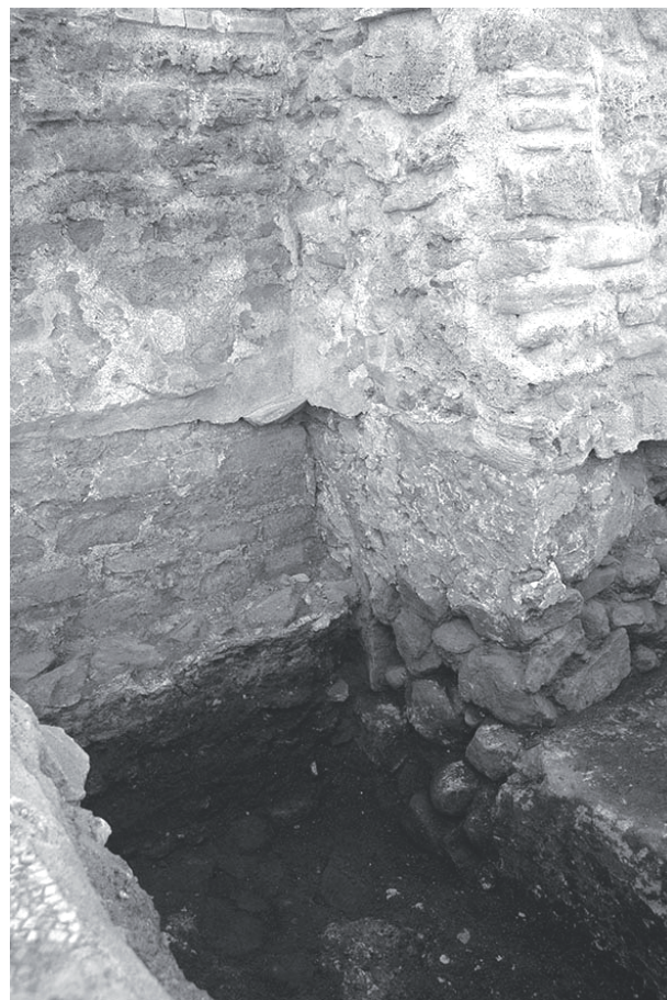
Fig. 7 - Nora, Area E, Ambiente Ta. Fondazione del perimetrale S in appoggio al perimetrale E del frigidarium .
