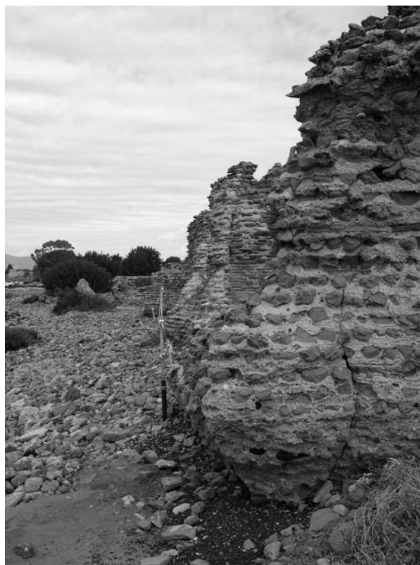
Fig. 6 - Le Terme a mare, particolare delle murature in cementizio.
