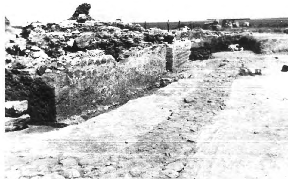
PULA - NORA: Le Terme Centrali Il muro perimetrale al di fuori dell'USM 37 e il corridoio di servizio
