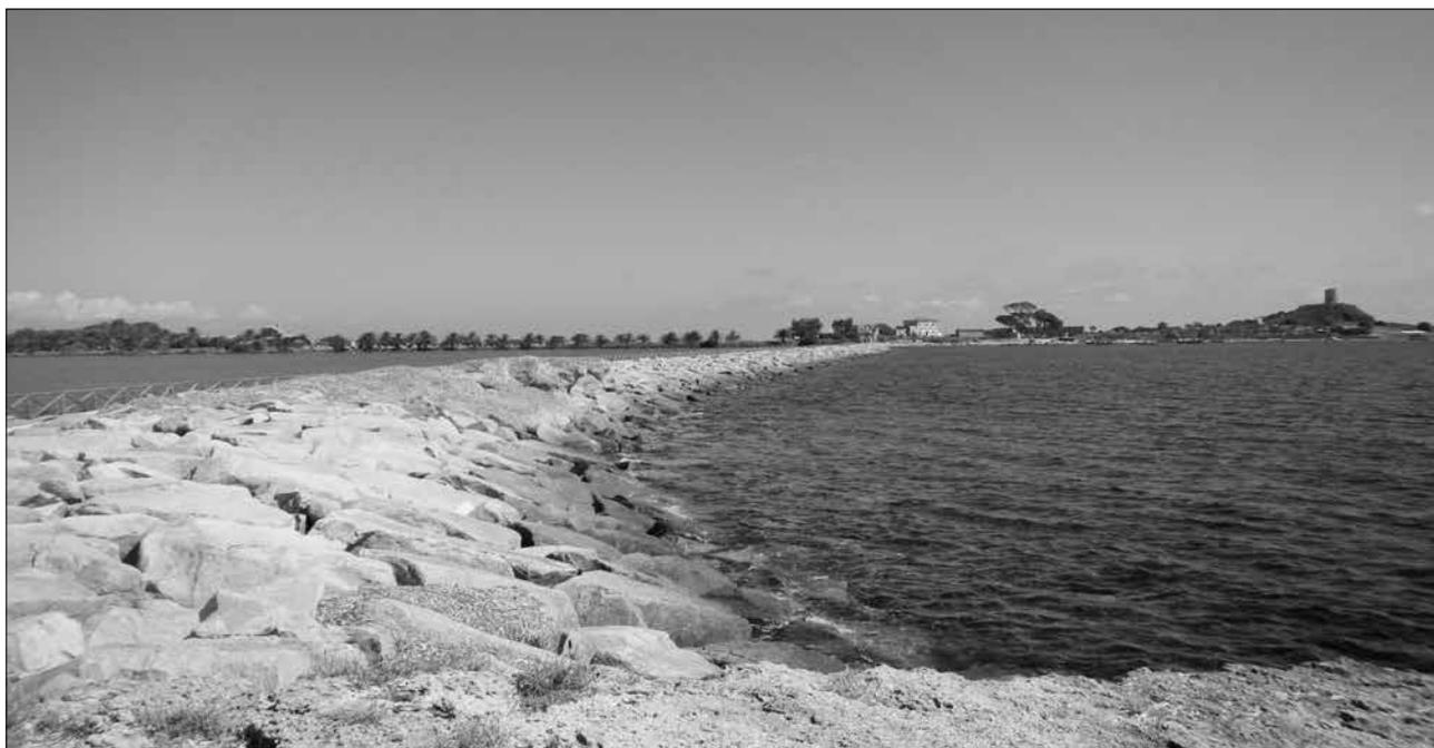
Fig. 15. La diga in blocchi di granito che collega la penisola di Is Fradis Minoris al promontorio di Nora.
