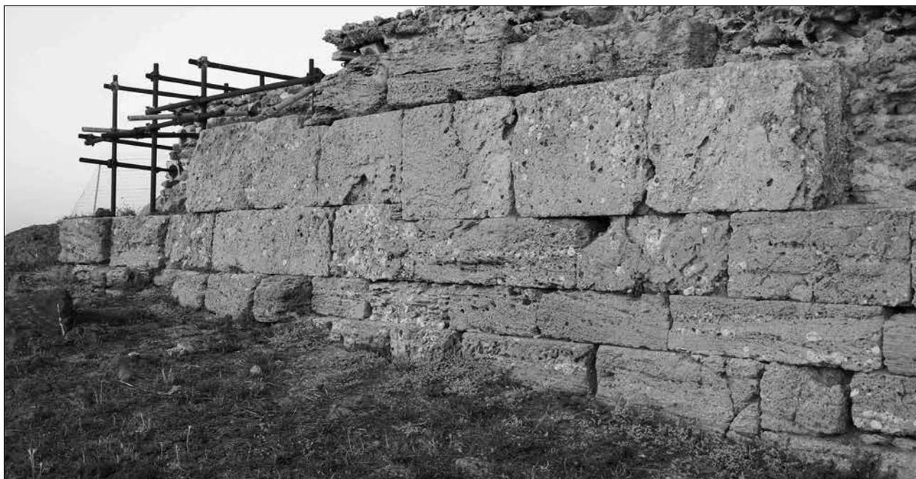
Fig. 80. Blocchi di arenaria tirreniana in opera nel muro orientale del santuario di Eshmun.
