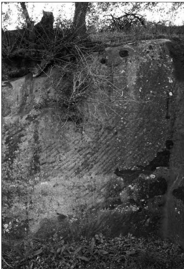
Fig. 120. Tracce di piccone con andamento “a festoni” su un fronte di cava.
