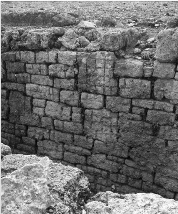
Fig. 83. Blocchetti di arenaria impiegati nelle pareti di una cisterna di Nora, con incisioni funzionali a favorire l'aderenza della malta di rivestimento.
