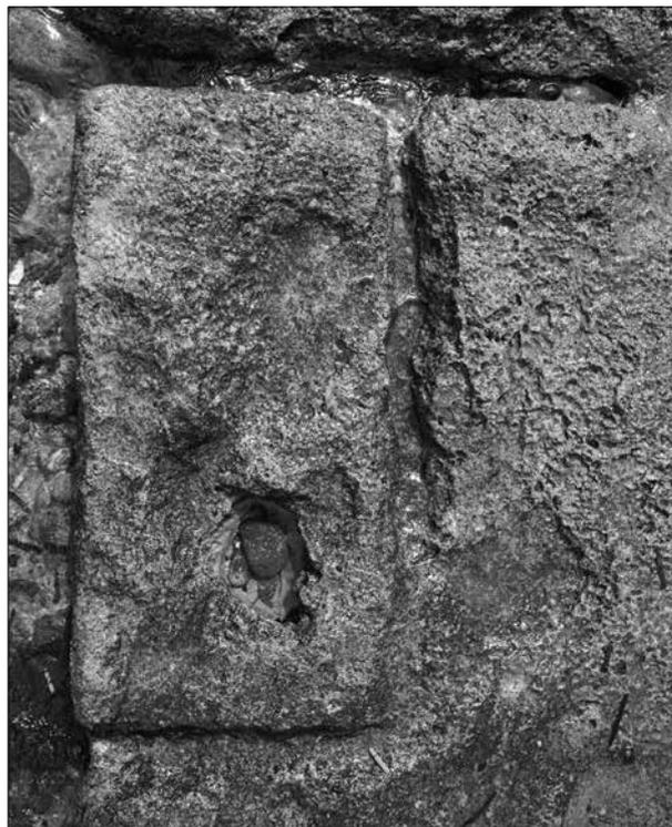
Fig. 69. Trincee di separazione tra i blocchi.
