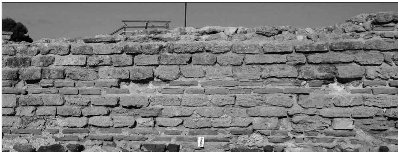
Fig. 142. Paramento in blocchetti di arenaria del muro della cella del Tempio romano.
