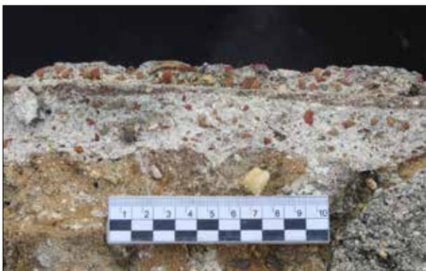
Fig. 62. Gli strati di rivestimento in malta presenti sulle pareti della cisterna.
