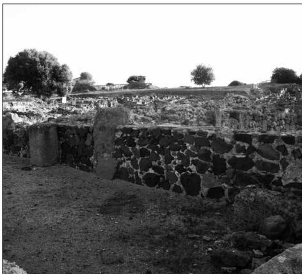
Fig. 114. *Macellum*. Blocco squadrato di andesite utilizzato come piedritto in una struttura muraria con corpo in scapoli dello stesso materiale.
