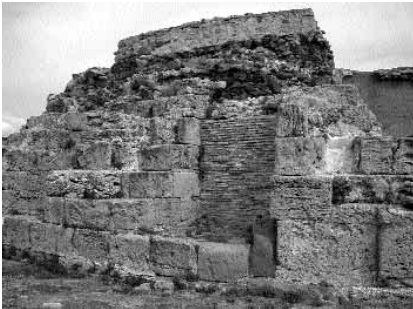
Fig. 6 - Nora. Prospetto esterno del teatro in opera quadrata con il contestuale impiego dell'opera cementizia e dei laterizi nelle strutture di contenimento.
