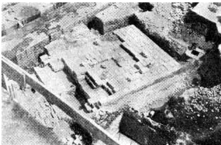
Fig. 13 - Cagliari. Tempio di Via Malta (da MINGAZZINI 1949).
