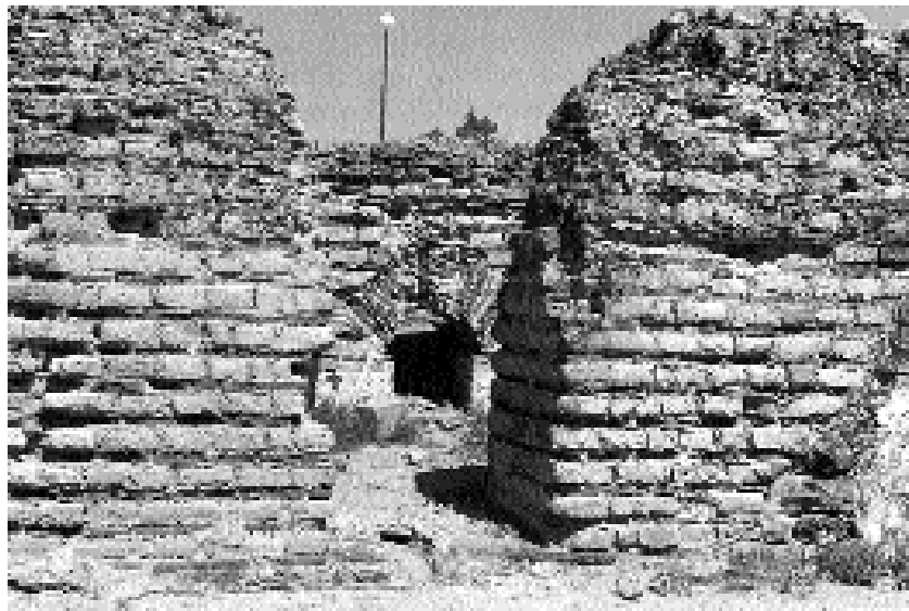
Fig. 8 - Fordongianus. Strutture in opera mista a fasce nelle Terme II (da ZUCCA 1986a).
