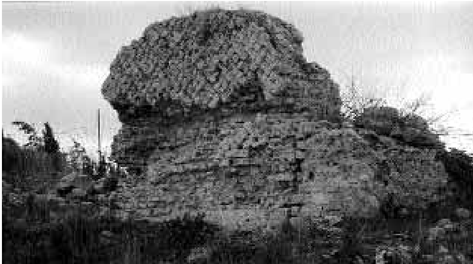
Fig. 7 - Sassari, Ottava. Resti dell'acquedotto turritano in opera reticolata (da SATTA 2000).
