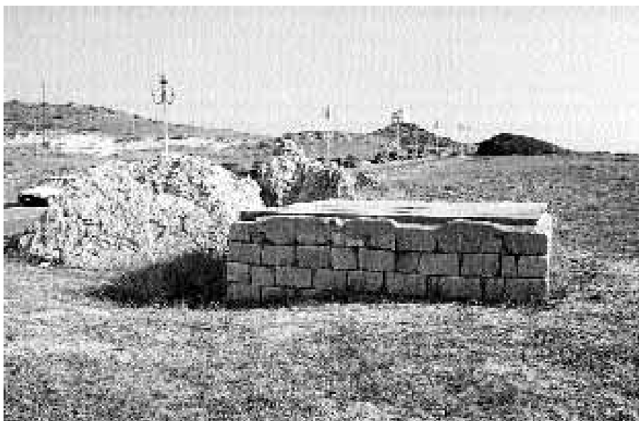
Fig. 75 - Tharros. Pozzo di captazione dell'acquedotto (da GIORGETTI 1999).
