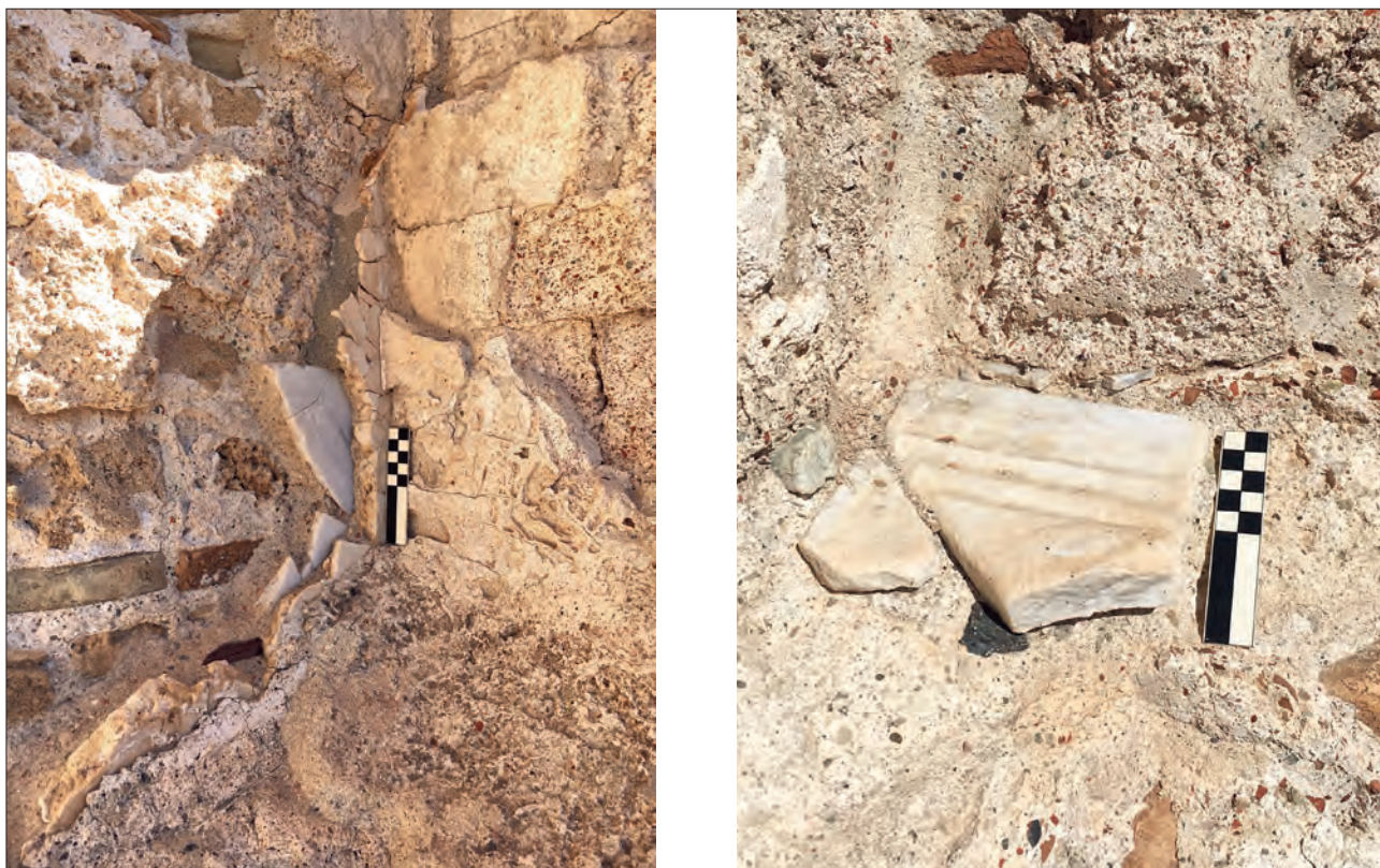
Fig. 4. Rivestimento parietale della vasca delle Piccole Terme.
